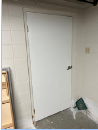
Existing Armory Door
