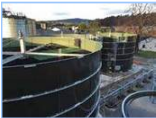
Trickling Filters.jpg
