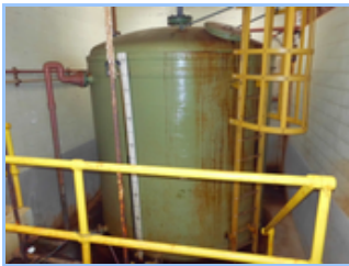
Ferrous Bulk Tank.JPG
